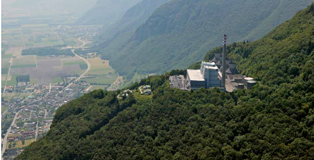
Centrale thermique de Chavalon Wärmeleistung Chavalon
