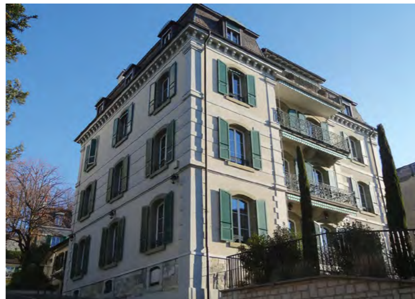
Siège EOS Holding Lausanne (Suisse) EOS Holding headquarters, Lausanne (Switzerland)
